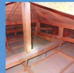
屋根裏の水抜きに
