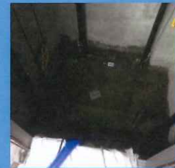
エレベーターピットの水抜きに
