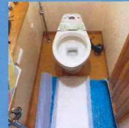
トイレ設置工事に
