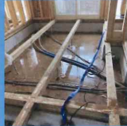
住宅基礎工事の水抜き
